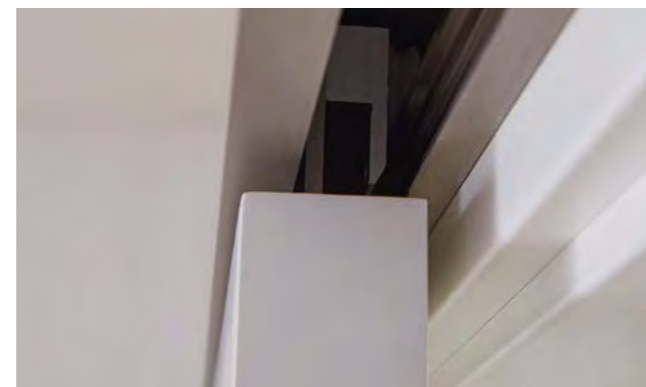
Befestigung einer Holztür im Schiebetürbeschlag SLIM
